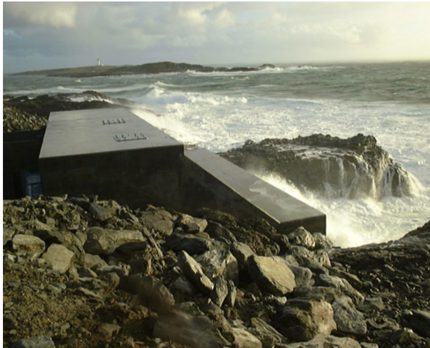
Abb. 4 - 9 Pneumatische Kammer. Schematische Darstellung (oben) und Fotografie (unten). 16
